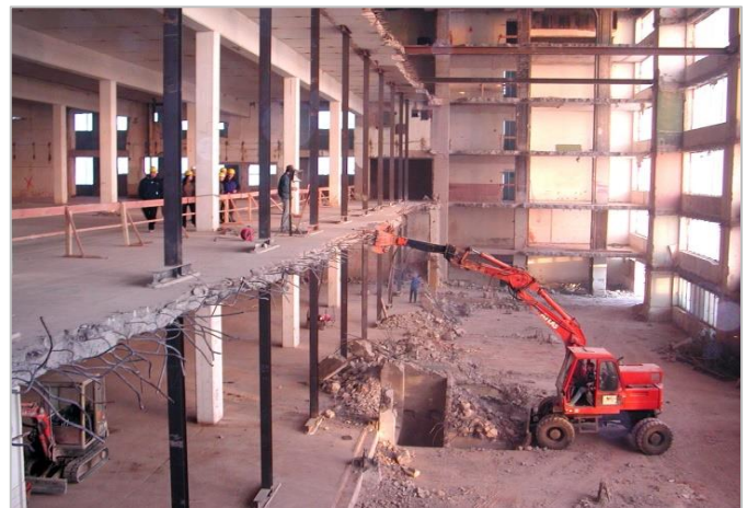
شكل رقم 5: يوضح عملية هدم جزء من بلاطات المبنى اثناء ضم فراغاته لإعادة تأهيله إلى مكتبة.
