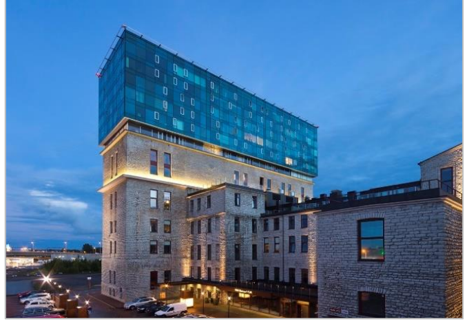
شكل رقم 8: منظر لمبنى المصنع يعتليه الصندوق الزجاجي للشقق السكنية.
